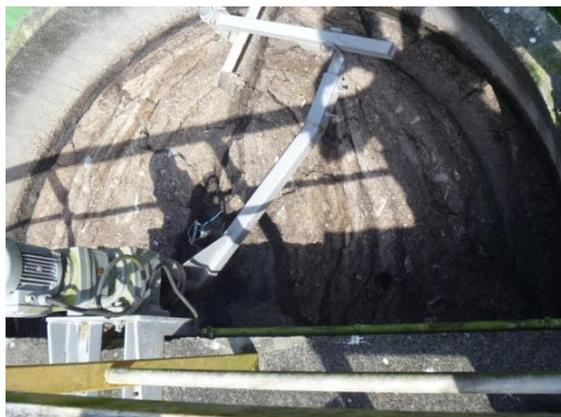
Figure 2.1 - Prétraitements : dégraisseur
