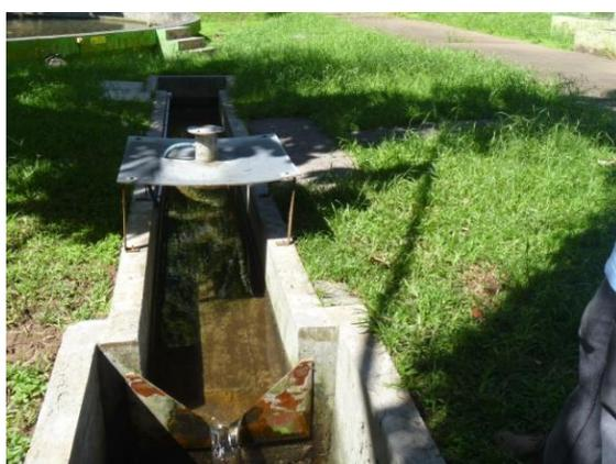
Figure 2.4 - Canal venturi en sortie
